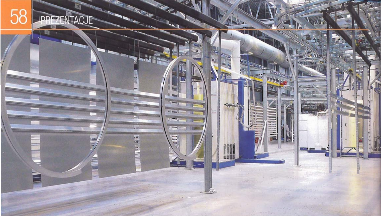
Detale w taworze przed gniazdem malowania proszkowego.
